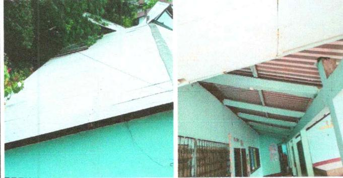
Foto No. 1: Sustrucción de lamina por lamina troquelada, sustrucción de capote de lamina para lamina troquelada y sustrucción de estructura de soporte de madera por metal
