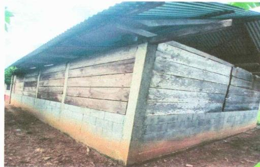
Foto 8: reparación de pared con solera y columnas
