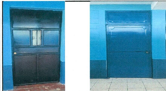
Foto 3. Puertas pintadas en los módulos 1, 2,3 y 4.
