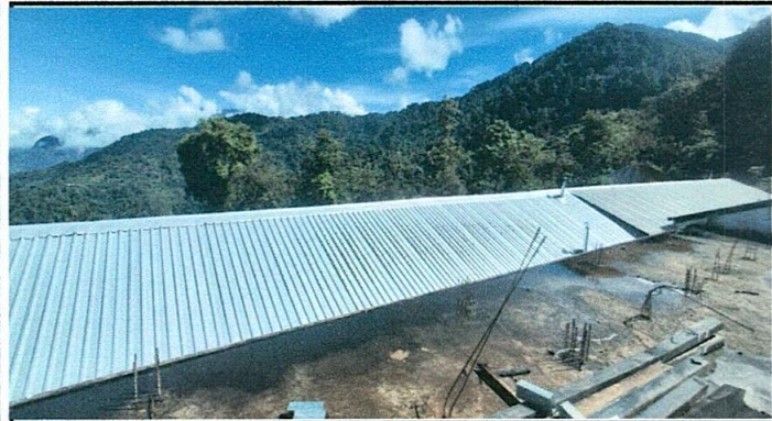
Foto 1. Techo nuevo instalado.
