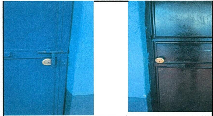
Foto 4. Chapas nuevas colocadas en cada puerta.
