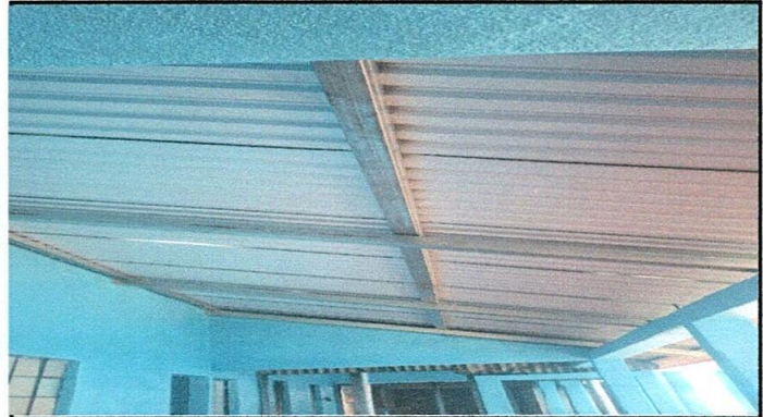
Foto 2. Costaneras instaladas.
