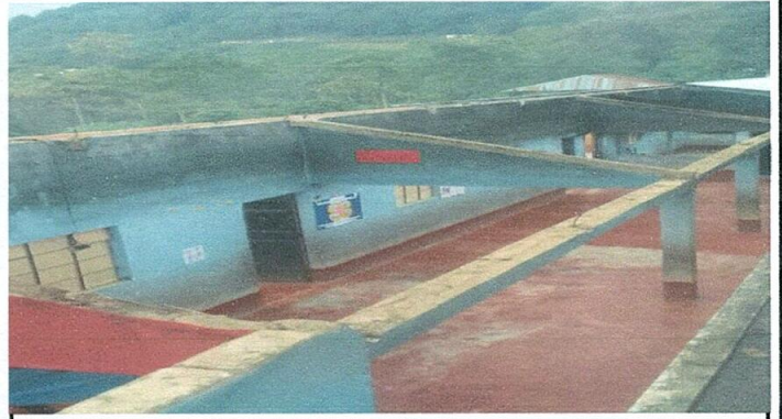
Foto 2. Cambio de costaneras en proceso.
