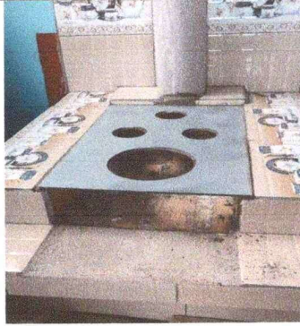
Foto 1: Sustrucción estufa rural incluye chimenea y plancha
