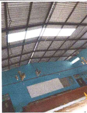
Foto 3: Sustrucción de laminas por laminas troqueladas
