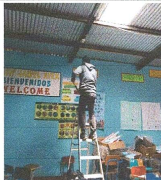
Foto 6: Sustitución de focos ahorradores
