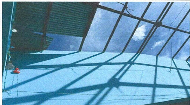
Foto 1: Sustitución de láminas
