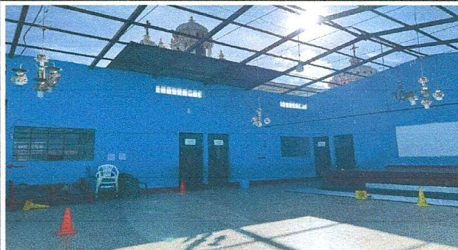
Foto 2: Sustitución de costaneras
