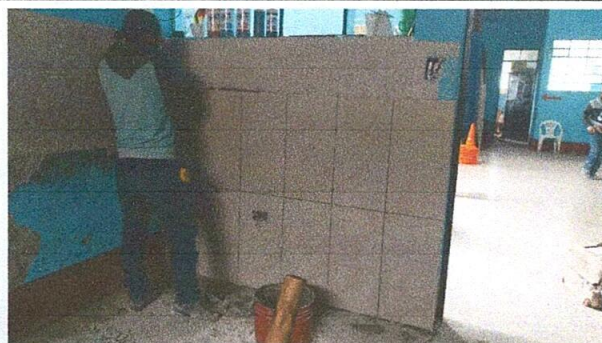
Foto 3: Sustitución de pared por azulejos
