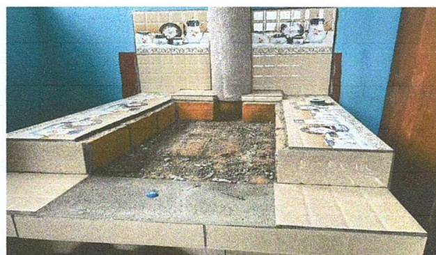
Foto 4: Sustitución de plancha
