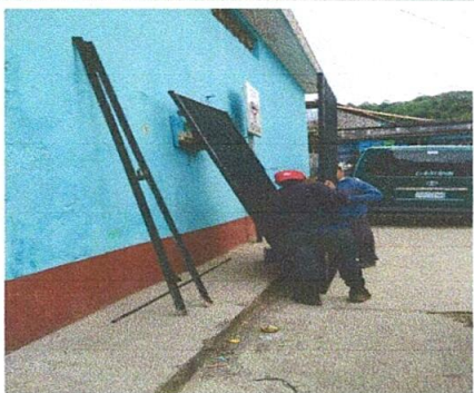
Foto 5: Sustitución de portón principal
