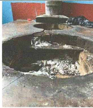
Foto 2: Sustitución de Plancha rural con chimenea
