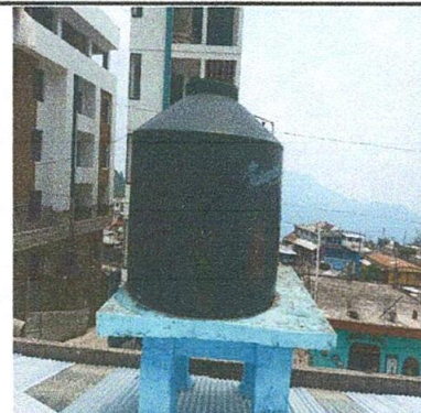
Foto 4: Sustitución de Rotoplas
