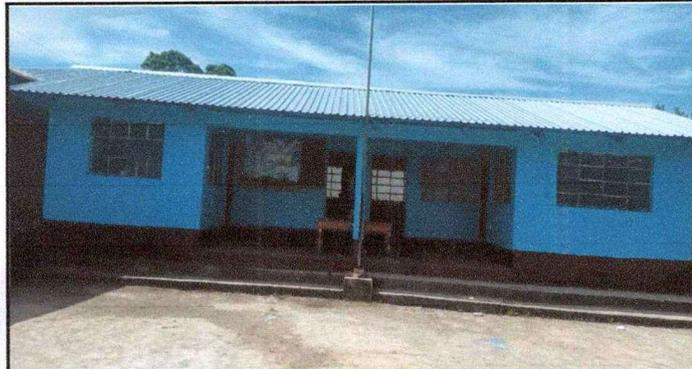
FOTO 1. CAMBIO DE ESTRUCTURA DE TECHO Y LÁMINA TROQUELADA.
