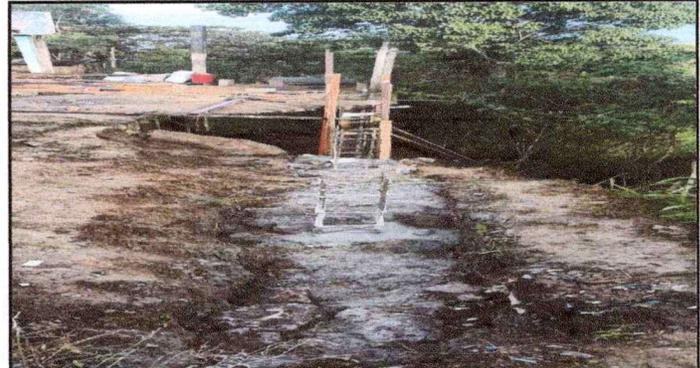
FOTO 4. REPARACIÓN DE MURO DE CONTENSIÓN EN PROCESO.
