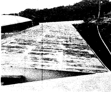
Foto 1: lámina en malas condiciones
