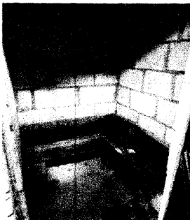
Foto 5: sustitución de mingitorios
