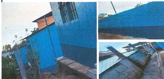
FOTO No. 7 el perímetro de circulación y muro ya esta reparado
