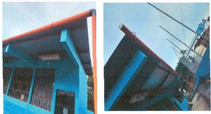
FOTO No. 3 estan colocando los tubos PVC
