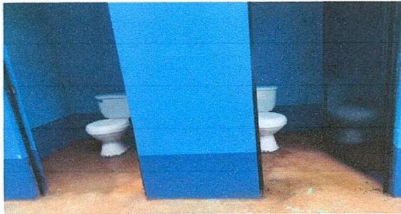
FOTO No. 5 ya se colocaron los inodoros nuevos
