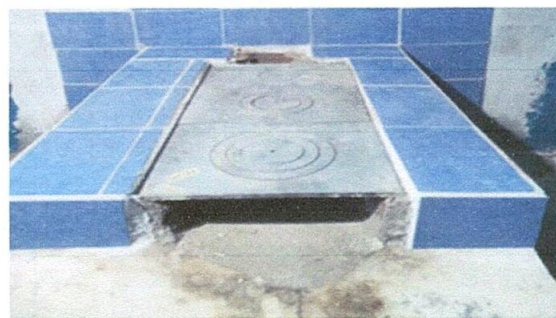
FOTO No. 10. estan reparando la plancha y colocando azulejo a la estufa rural
