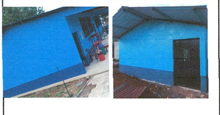
FOTO No. 4 ya estan pintadas las paredes de las escuelas, cocinas y servicios sanitarios
