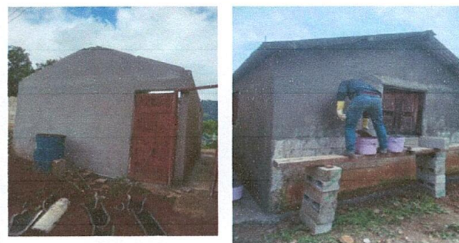
FOTO No. 12 están repellando las paredes de la cocina
