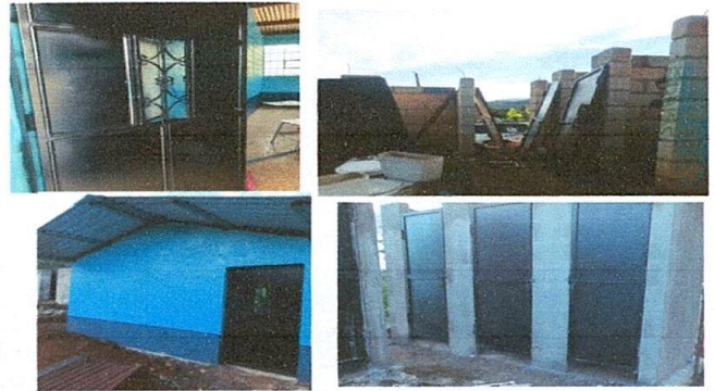
FOTO No. 2 se estan cambiando las puertas
