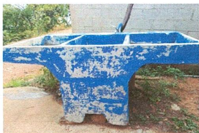
FOTO No. 11: pila en mal estado por eso se requiere de sustitución.
