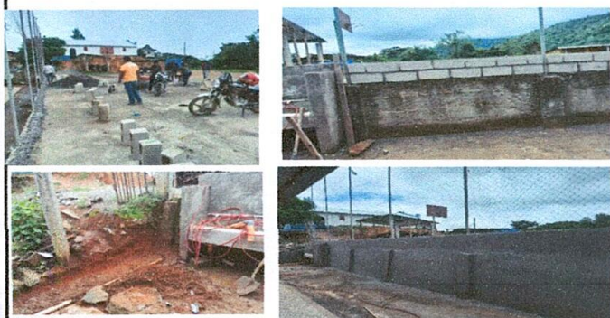
FOTO No. 7 el perímetro de la circulación y muro están reparando
