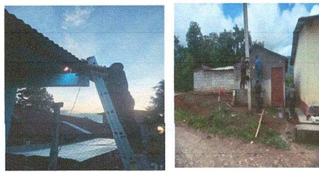
FOTO No. 8 El cableado del sistema eléctrico están reparando
