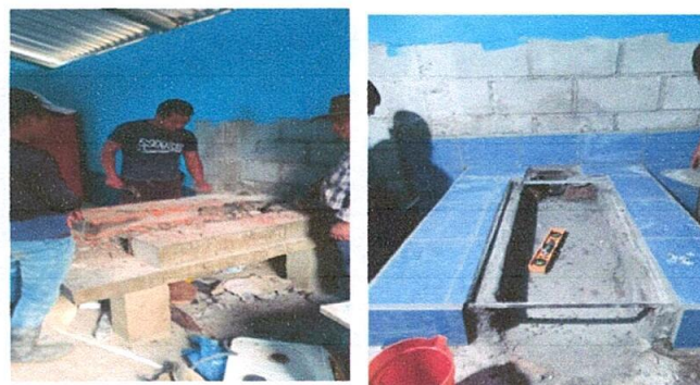
FOTO No. 10. están reparando la plancha y colocando azulejo a la estufa rural
