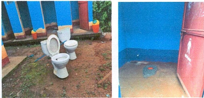
FOTO No. 5 ya estan colocando los inodoros
