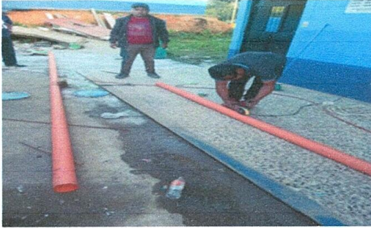
FOTO No. 3 estan colocando los tubos PVC
