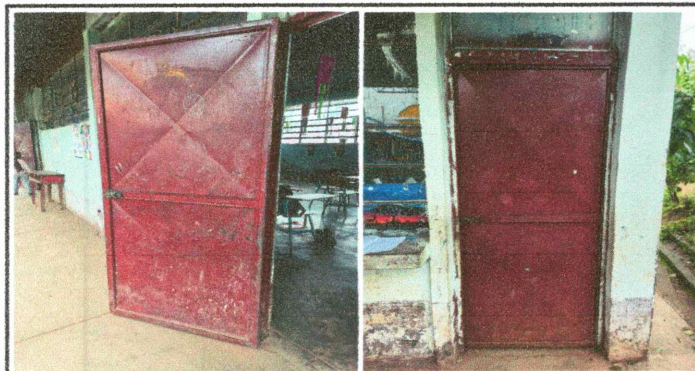
Foto 3: sustitución de puertas de aulas
