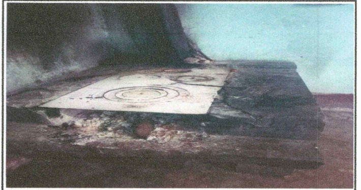
Foto 8: sustitución de estufa rural (completa) incluye chimenea y plancha de metal
