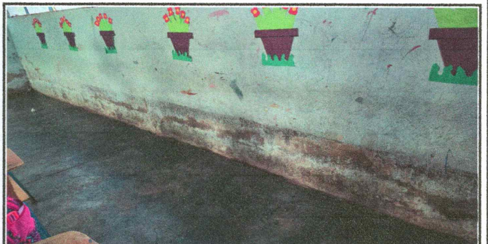
Foto 6: aplicación de pintura en muros exteriores e interiores
