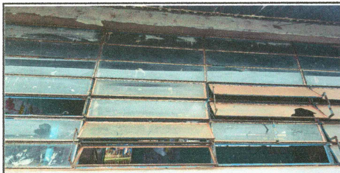
Foto 5: sustitución de vidrios
