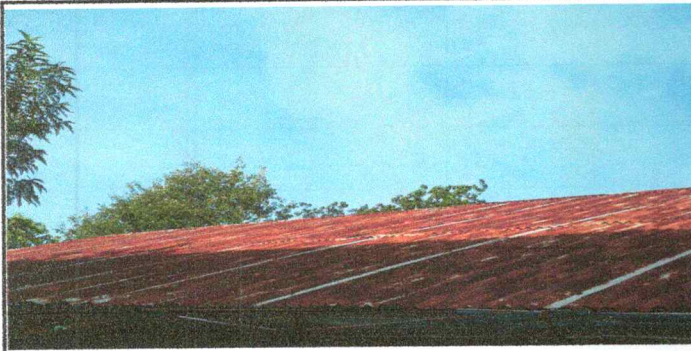
Foto 1: sustitución de laminas, por lamina troquelada aluzinc calibre 26
