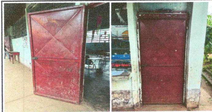
Foto 3: sustitución de puertas de aulas
