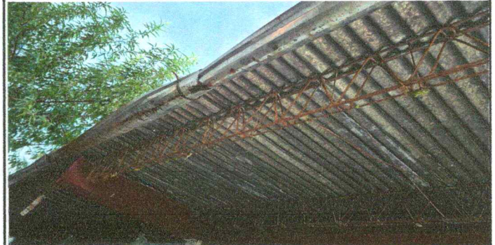
Foto 2: sustitución de estructura de soporte de metal por metal
