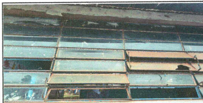
Foto 5: sustitución de vidrios
