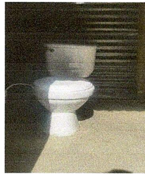
Foto 10: Sanitario nuevo instalado
