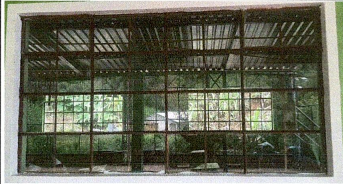
Foto 1: Finalización de colocación de ventanas
