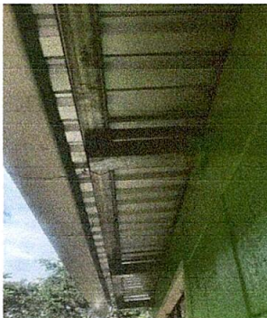
Foto 5: Estructura de soporte reemplazado
