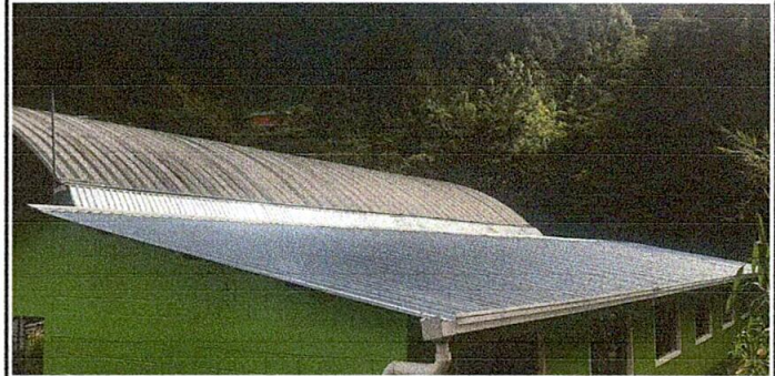
Foto 6: Láminas y clavos renovados
