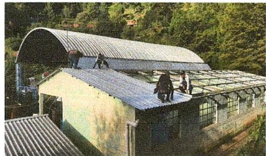
Foto 6: Colocación de láminas
