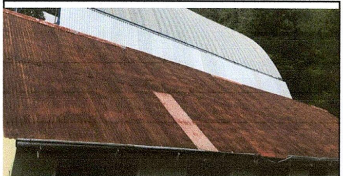
Foto 6: Laminas y clavos oxidados
