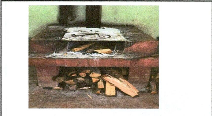
Foto 8: Plancha oxidada
