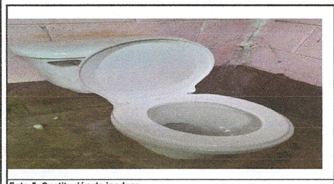
Foto 5: Sustitución de inodoro.
