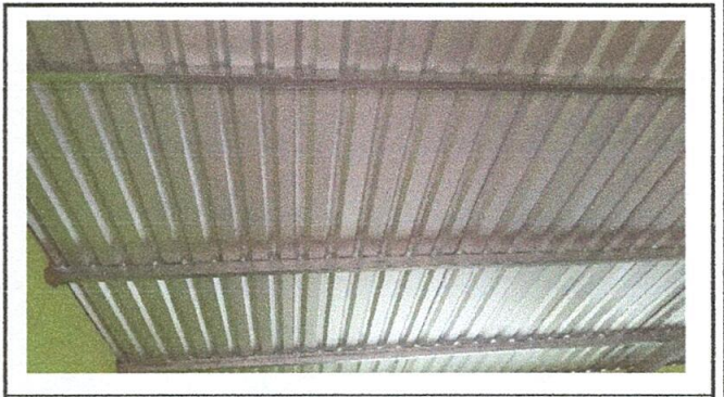
Foto 4: Sustitucion de láminas troqueladas, por malas condiciones.
