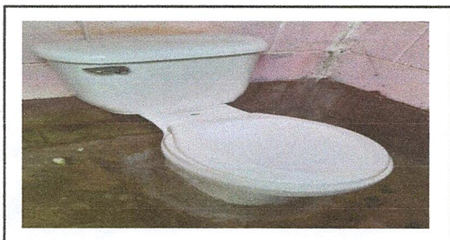
Foto 5: Sustitución de inodoro.
