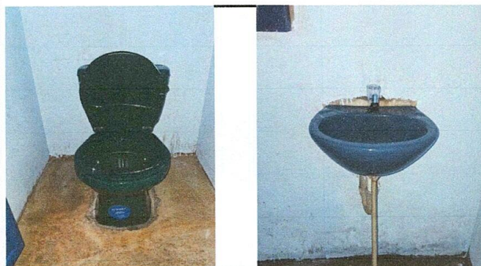
Foto 3: Sustitución de inodoro y lavamanos
