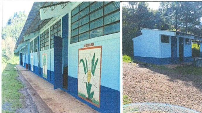
Foto 2: Pintura en muros exteriores e interiores
