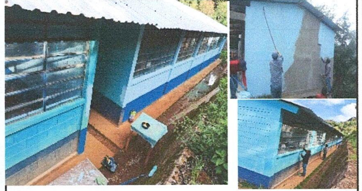
Foto 2: Pintura en muros exteriores e interiores
