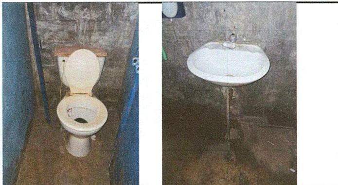
Foto 3: Sustitución de inodoro y lavamanos
