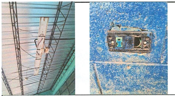
Foto 5: Reparación de lámparas, sustitución de tomacorrientes dobles y reparación de cableado eléctrico
