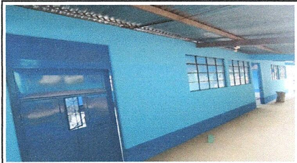
Foto 1. Así quedó la parte externa de la escuela después de la pintura de las paredes.
