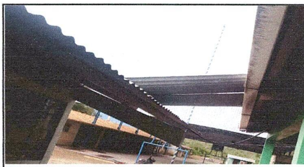
Foto 6. La mayoría de las láminas que cubren el techo frontal de la escuela ya se cayeron, cuando hay lluvia entra mucho el agua y se mojan los niños.
