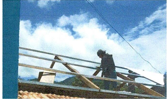
Foto 2: ESTRUCTURA DE TECHO DE COCINA
