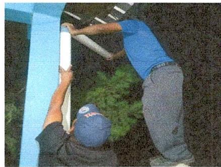
Foto 6: CANALES Y BAJADAS DE AGUA
