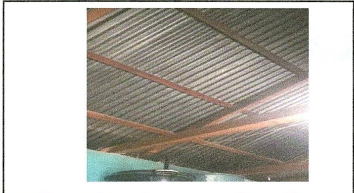
Foto 2: ESTRUCTURA DE TECHO DE COCINA
