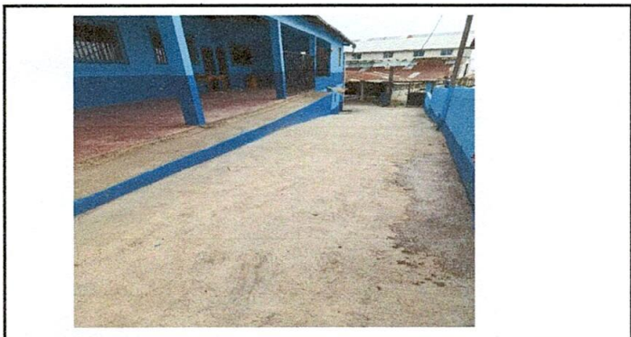
Foto 11: Reparacion de plancha de concreto de patio
