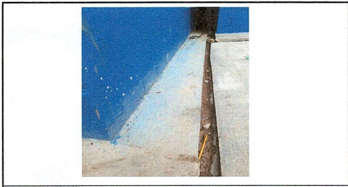
Foto 5: Reparacion de banqueta de concreto
