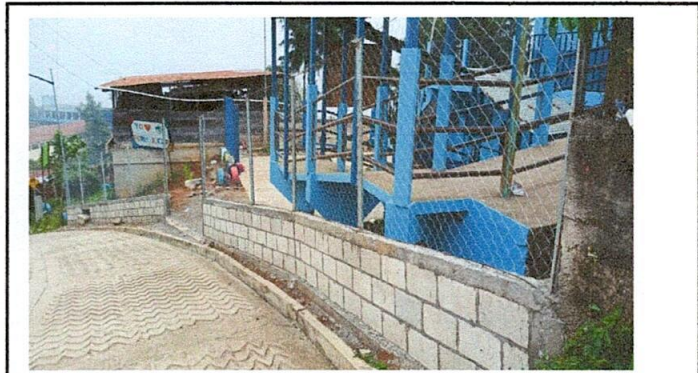
Foto 10: Reparación de muro perimetral con tubo hg y malla galvanizada
