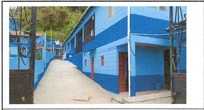
Foto 6: Pintura de muros exteriores e interiores
