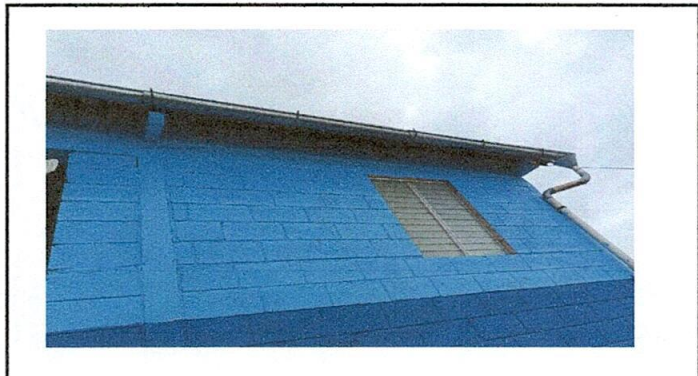
Foto 4: Sustitución de canal de metal
