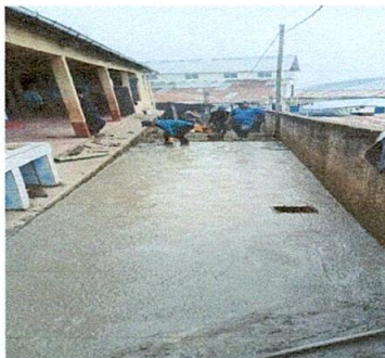
Foto 5: Reparación de planchas de concreto de patio
