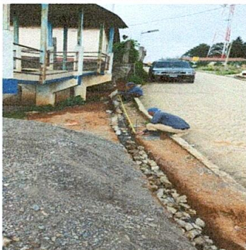
Foto 1: Reparación de muro perimetral
