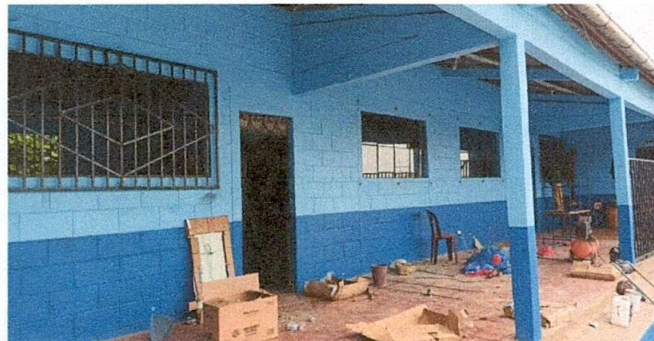
Foto 2: Sustitución de vidrios.
