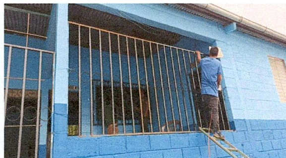
Foto 4: Mantenimiento a barandas de metal
