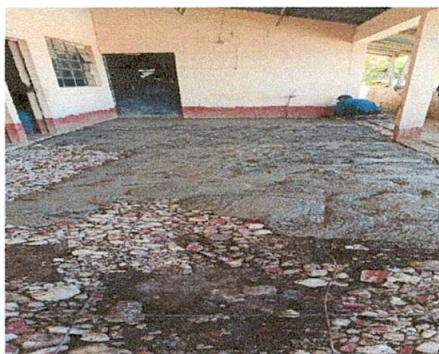
Foto 3: Sustitución de piso de torta de concreto
