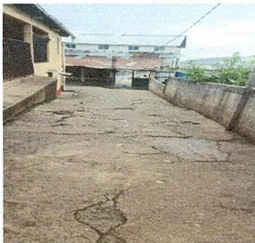
Foto 11: Reparación de plancha de concreto de patio
