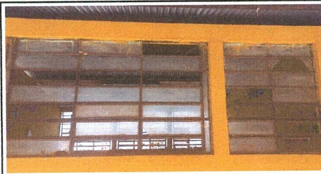
Foto. 3 Sustitución de vidrios
