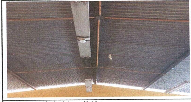
Foto 6. Sustitución de sistema eléctrico
