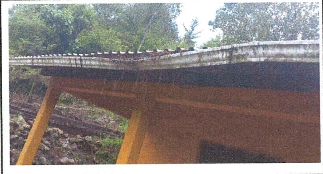
Foto 4. Sustitución de canal de metal
