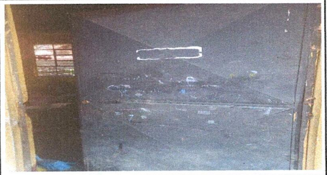
Foto 2. Pintura de puertas y cambio de chapas
