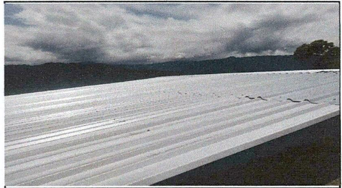
Foto 4: Mejoramiento de techo de la escuela.
