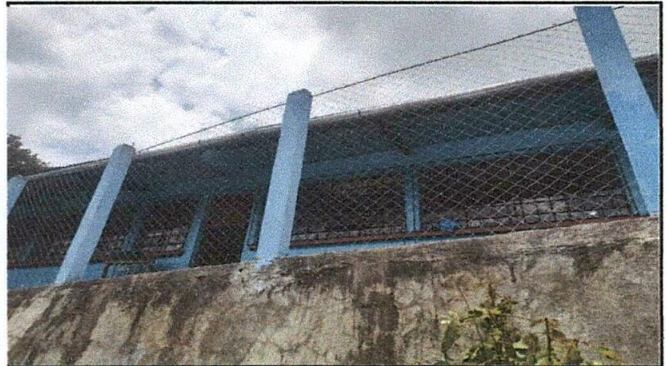
Foto 2: Mejoramiento de columnas y malla sobre el muro perimetral.
