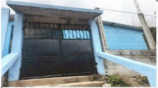
Foto 3: Instalacion de nuevo portón.
