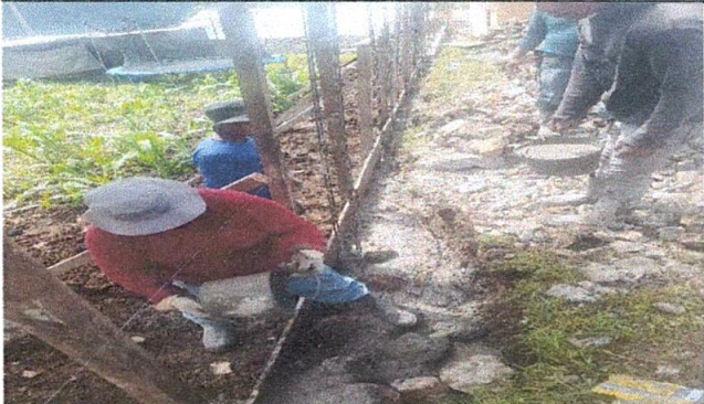
Foto1: Mejoramiento de la circulación de la escuela.
