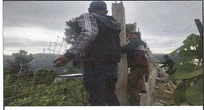
Foto 4: Mejoramiento de columnas y malla del muro.
