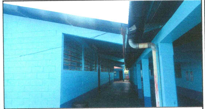
Foto 2: Reparación de canales de bajadas de agua
