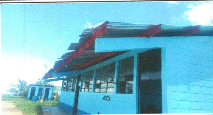
Foto1: Sustitución de Techo
