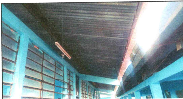
Foto 3: Reparación de sistema electrico
