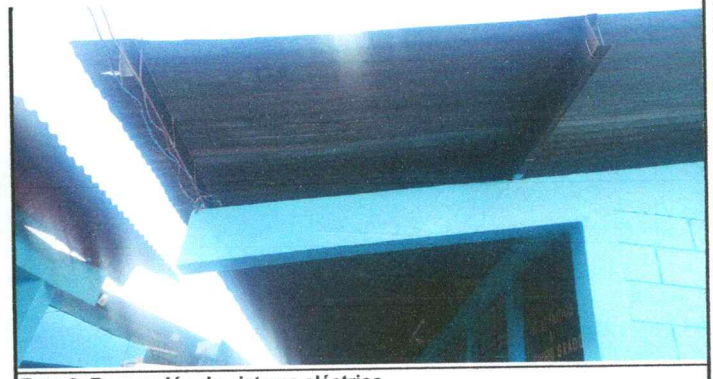
Foto 6: Reparación de sistema eléctrico.
