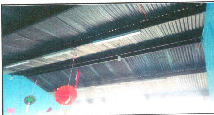
Foto 5: Reparación de sistema eléctrico.
