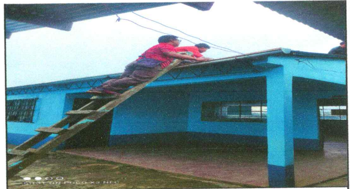
Foto 4: Sustitución de techo
