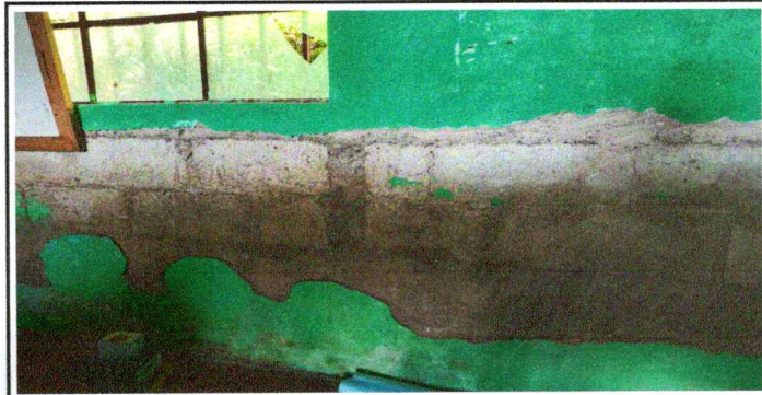
Foto 6: Vista del interior de las aulas del módulo antiguo
