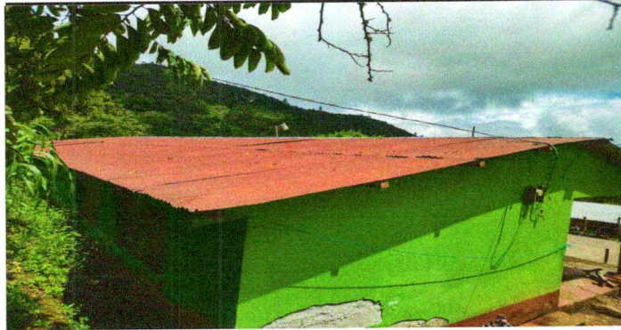
Foto 1: Vista del techo del edificio, módulo antiguo
