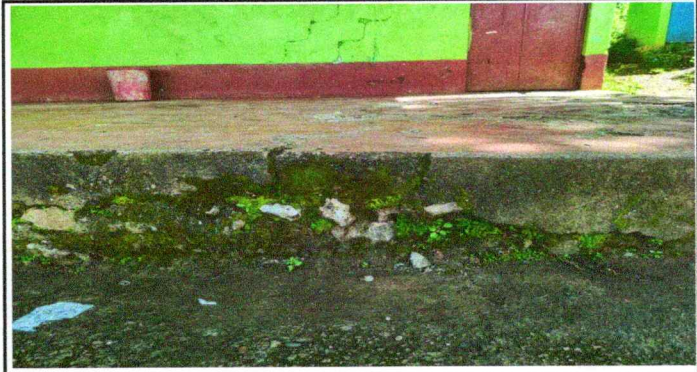
Foto 4: Vista de los muros del edificio, módulo antiguo
