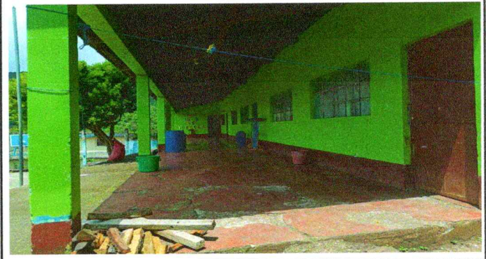
Foto 2: Vista del piso del edificio, módulo antiguo
