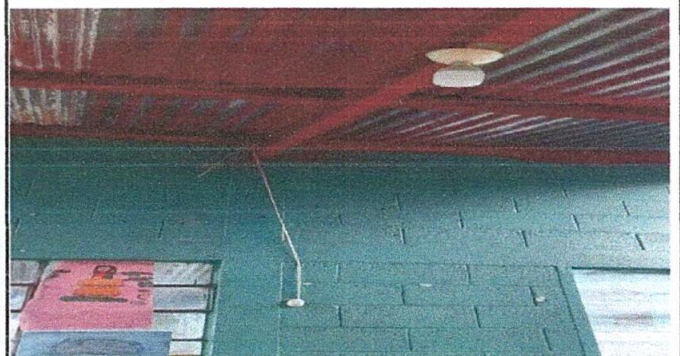
foto 8. Interruptor simple instalado
