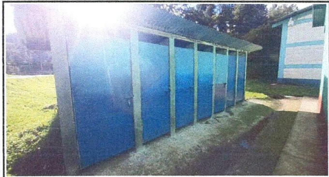
foto 4. Puertas instaladas en los servicios sanitarios
