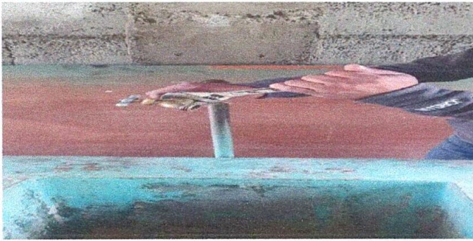
foto 9. Sustitución de lleve de chorro.
