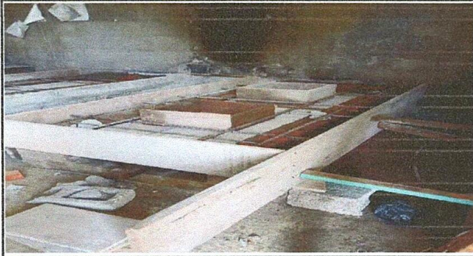
foto 1. Fundición de las planchas
