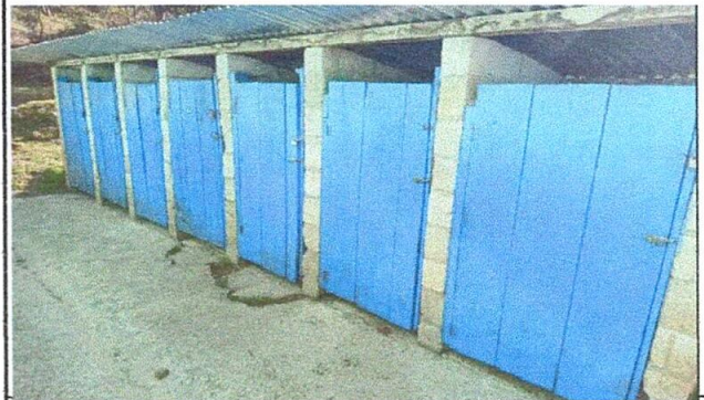
foto 4. sustitución de puertas
