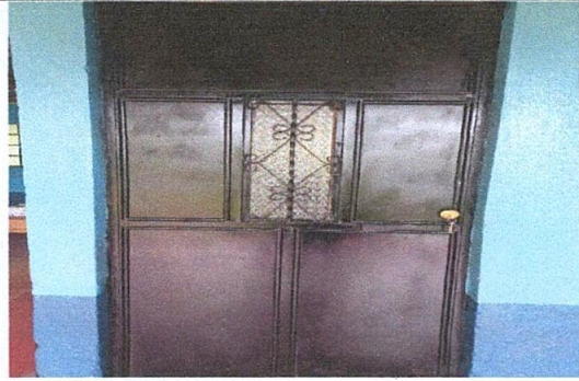
Foto 2. Pintura de puertas y cambio de chapas
