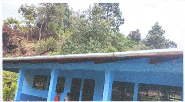
Foto 4. Sustitución de canal de metal
