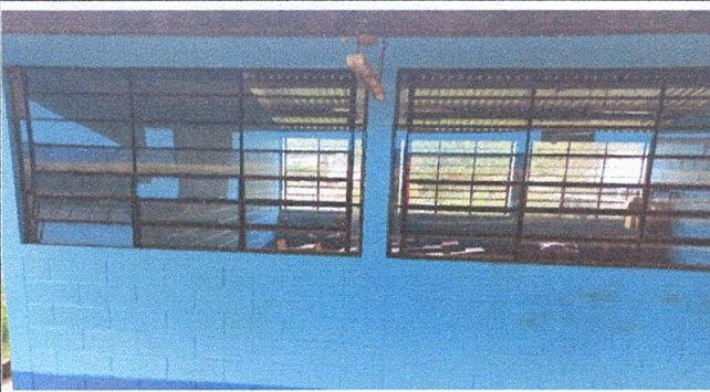
Foto. 3 Sustitución de vidrios
