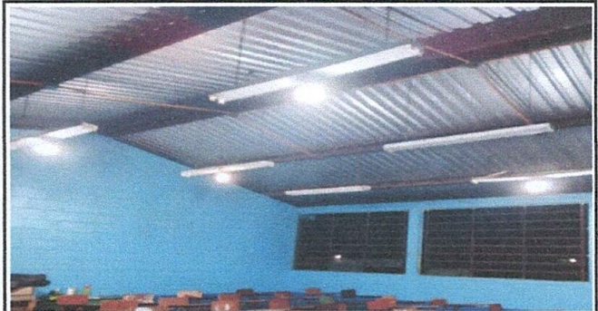
Foto 6. Sustitución de sistema eléctrico
