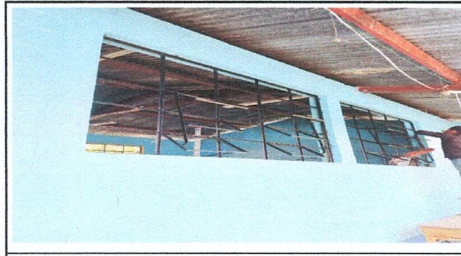
Foto. 3 Sustitución de vidrios
