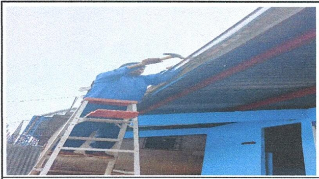
Foto 4. Sustitución de canal de metal
