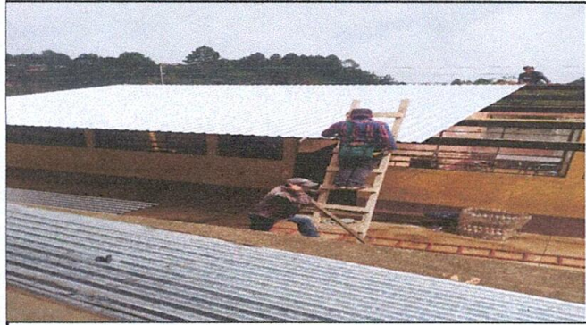
Foto.1 Sustitución de lámina, por lámina troquelada
