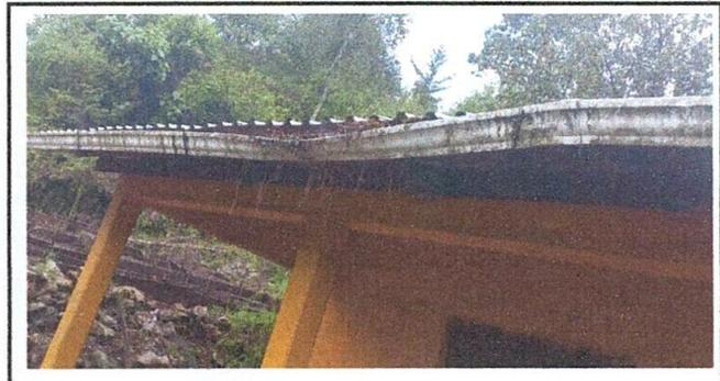
Foto 4. Sustitución de canal de metal
