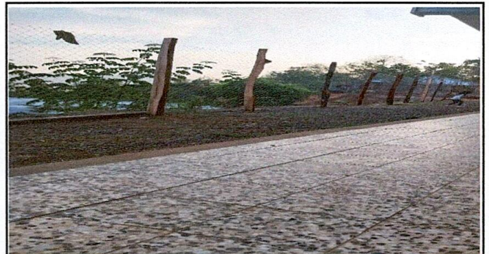
Foto 6: Sustitución de entortado en proceso
