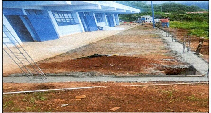
Foto 2: Reparación de muro perimetral
