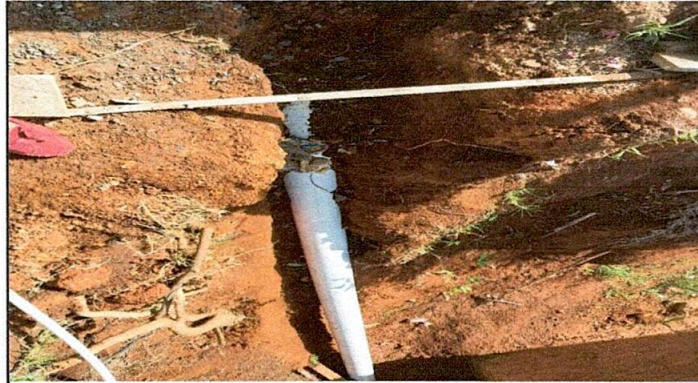
Foto 1: Sustitución de Vajada de agua Pluvial
