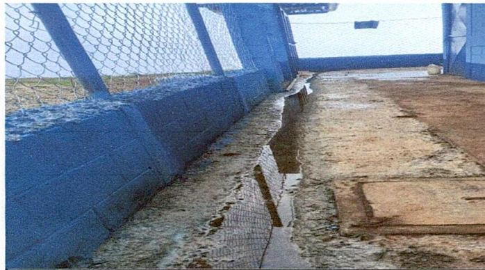
Foto 3: Reparación de cuneta
