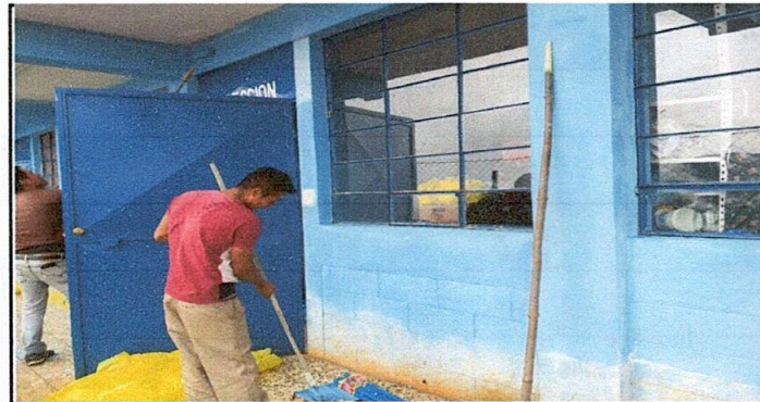
Foto 5: Pintura de exteriores e interiores
