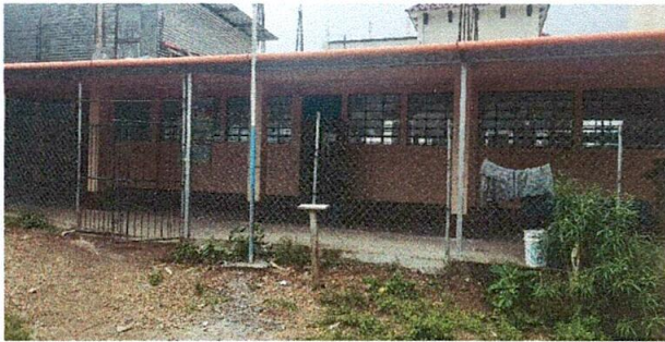
Foto 1: pintura en todas la aulas del Centro Educativo.
