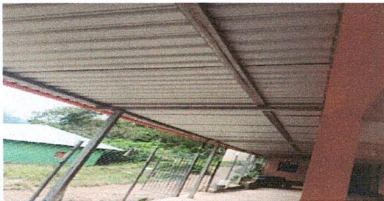
foto 5: entechado con lamina troquelada aluzinc
