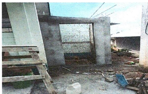
foto 6. Trabajo en los sanitarios del centro educativo
