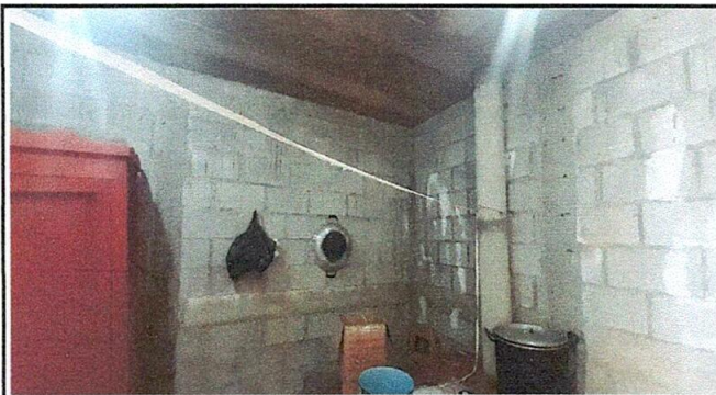
Foto 3: Repello y piso en la cocina
