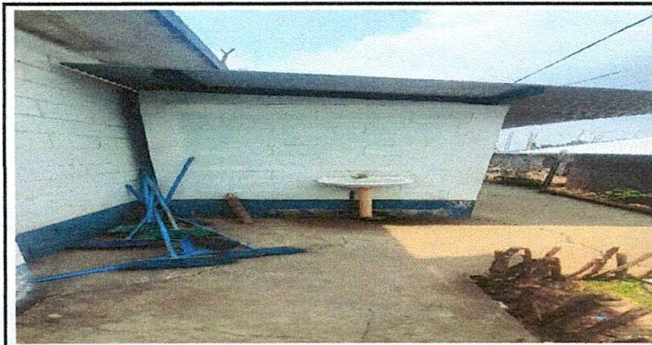
Foto 5: Pintar los tres baños del centro educativo
