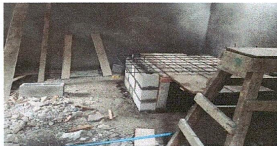
foto 2: construccion de la plancha de la conina,
