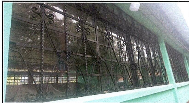
Foto 3: Ventanas balcón instaladas.
