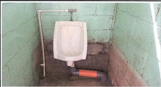
Foto 7: Mingitorio de porcelana instalado.
