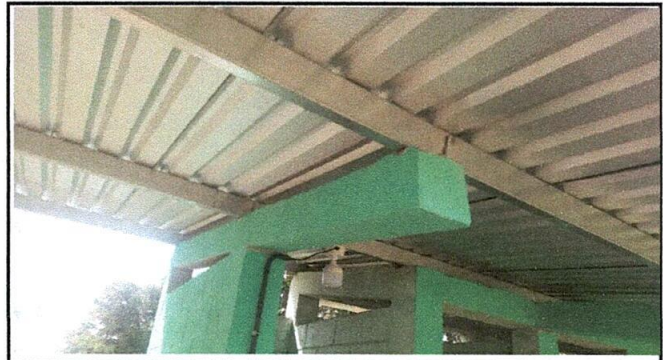
Foto 2: Estructura portante de techo de módulos de baños instalada.
