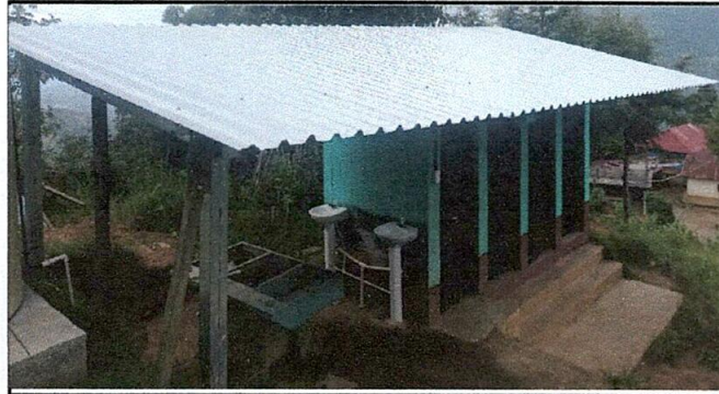
Foto 1: Techo de láminas troqueladas de módulos de baños instalado.
