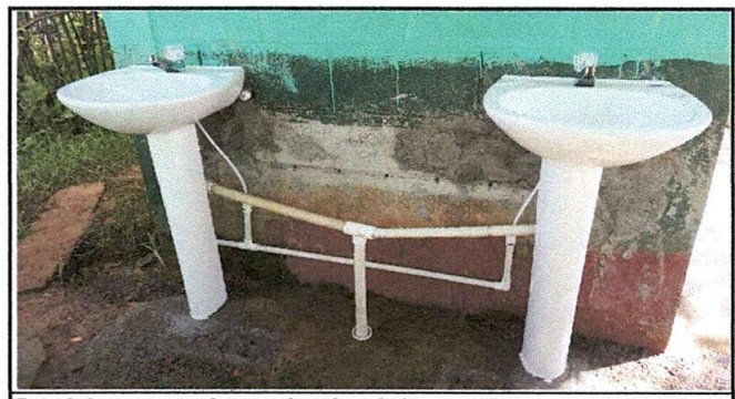
Foto 6: Lavamanos de porcelana instalados.
