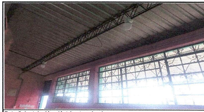
Foto 5: Instalación eléctrica terminada.
