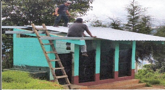
Foto 1: Instalación de láminas troqueladas de aluzinc calibre 26 en los techos de los módulos de baños.
