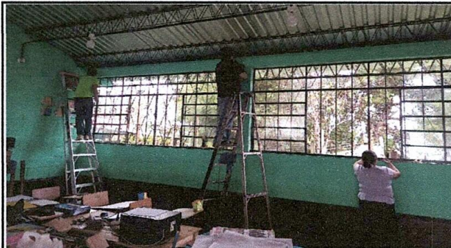
Foto 3: Inatación de ventanas balcón en las inataciones del módulo 1.
