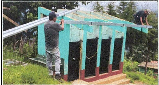
Foto 2: Instalación de costaneras para estructura portante de techo de los módulos de los baños.
