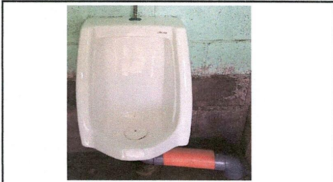
Foto 7: Instalación de mingitorio.
