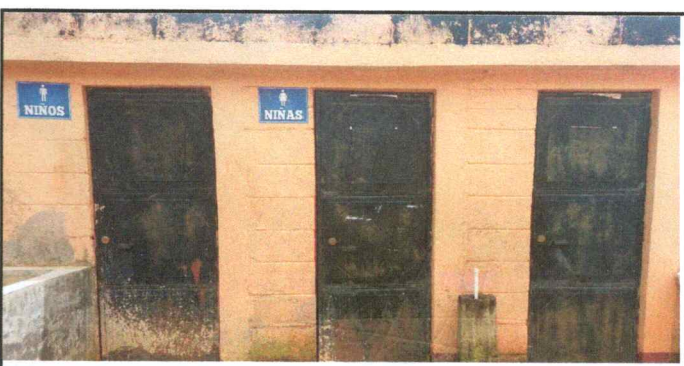
Foto 6: Puertas deterioradas por el oxido y desprendimiento de pintura.
