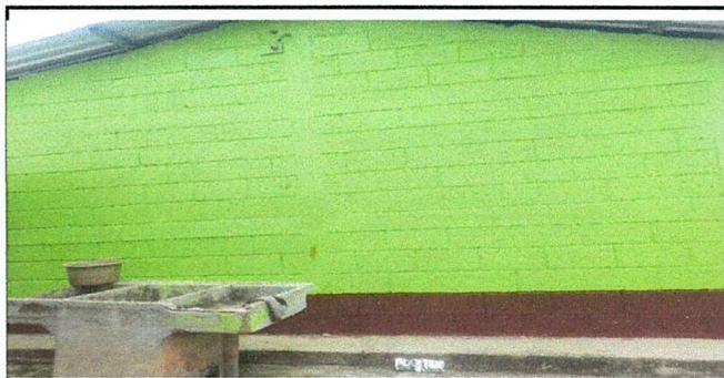
Foto 5: Cambio de pintura en el exterior e inferior.
