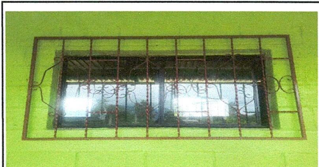
Foto 3: Sustitución de ventanas.
