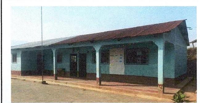
Foto 2: Cambio de lámina por lámina troquelada.
