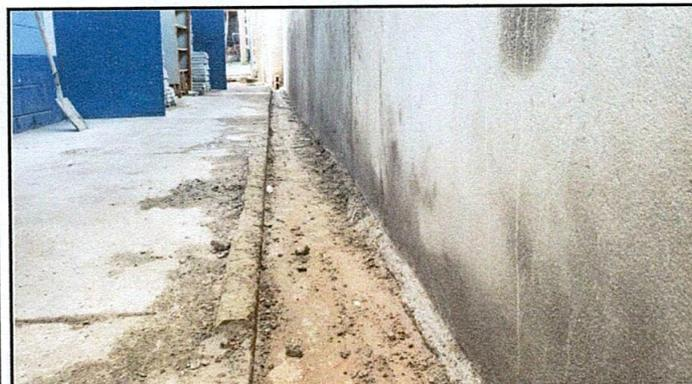
Foto 3: Se logra evidenciar el acabado final del muro de contención y la cuneta de concreto.
