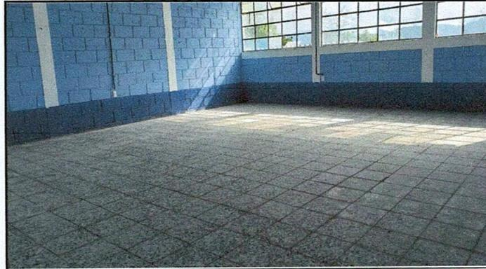
Foto 2: Se evidencia el proceso final de la sustitución de torta de concreto por pisos de granito en las dos aulas del establecimiento.
