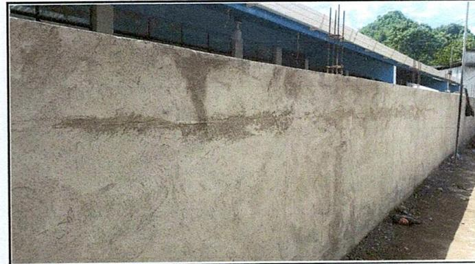
Foto 4: En la imagen se observa el acabado final del muro perimetral de block con soleras intermedias y columnas repellido en ambos lados.
