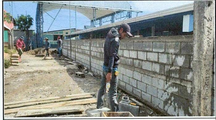
Foto 4: En la evidencia se puede apreciar el proceso de mantenimiento al muro perimetral de block con soleras intermedias y columnas.
