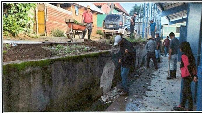
Foto 3: En esta imagen se aprecia el proceso de remodelación del muro de contención.
